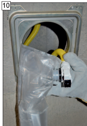
10 Bei fehlender Ableitung kann Kondensat- und Niederschlagswasser mit dem PARAT-Kondensatauffangbeutel, mit spezieller Sicherheitskupplung zum Beutelwechsel, gesammelt und entsorgt werden.
