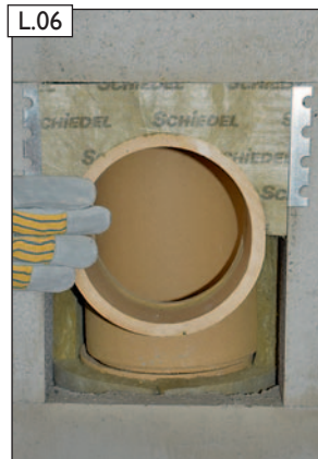
Frontplatte mit Haltwinkeln in die Mantelsteinöffnung einbringen und ...
