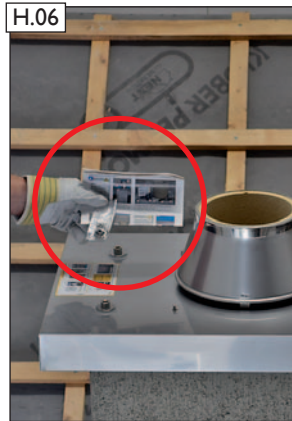
In der Montageanleitung der Edelstahlzuluftkopfplatte befindet sich das Befestigungsmaterial für die optionale Regenhaube „EAGLE“.
