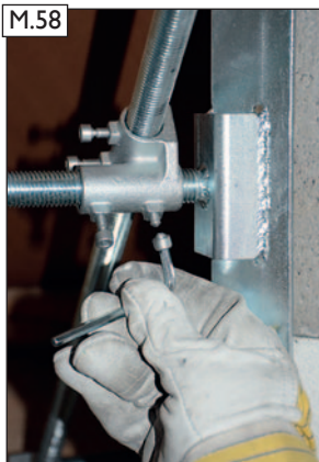
M.58 Spannwinkel an den Schornstein drücken. Abreißschrauben anziehen bis der Schraubkopf an der Sollbruchstelle abreißt.
