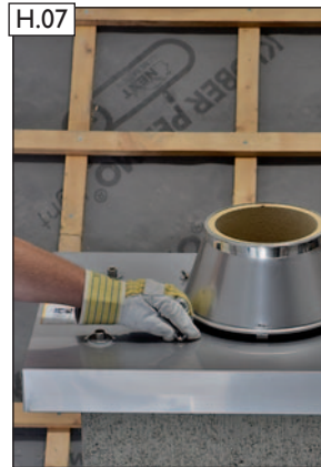
Beilagenscheiben und Flügelmuttern auf den beiden Befestigungsbolzen der Zuluftabdeckplatte montieren.
