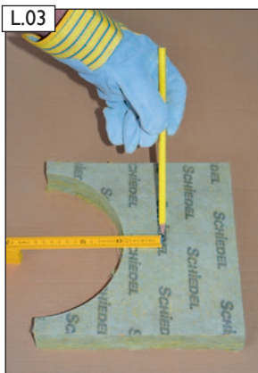
Öffnungsmaße auf Frontplatte übertragen.
