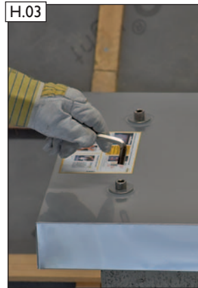
3. Edelstahl-Inbusschrauben M12 handfest anziehen .
