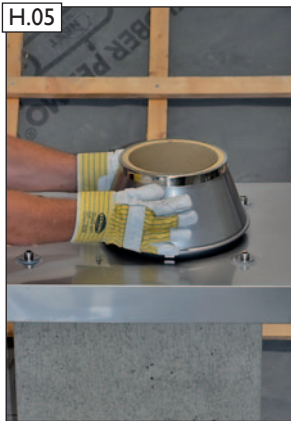
Konus bis ca. 2-3 cm auf Abdeckplatte schieben.
