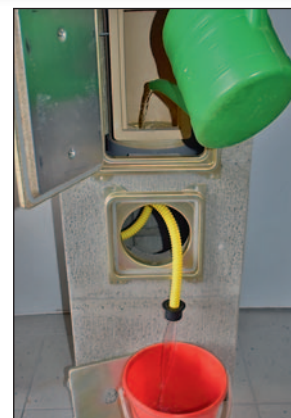
Kondensatteller und Siphonschlauch spülen.
