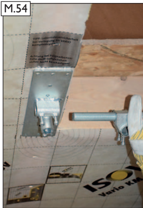
M.54 Gewindestange und 45° Spannwinkel wieder einfädeln und ausrichten.
