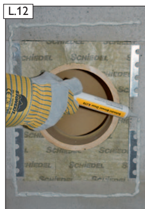
BlowerDoor A270 Dichtheitskleber ( vor Frost schützen ) auftragen - 8 mm Raupe. Ansicht des umlaufend vollständig geschlossenen Kleberauftrages.
