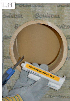
Verschluss aufschneiden und Tülle aufschrauben. Tüllenöffnung für ca. 8 mm Materialauftrag herstellen.
