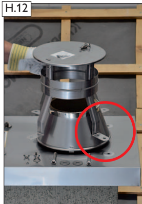
Regenhaube „EAGLE“ auf die Silikondichtungen aufsetzen.
