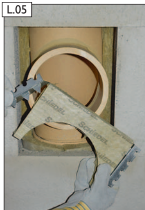
Haltwinkel in Frontplatte einstecken.
