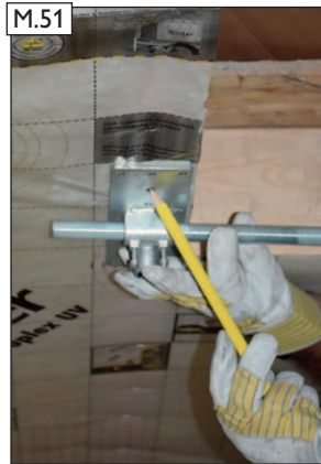
M.51 Aufgefädelte Einzelteile zum einrichten anhalten. Einbauposition für den Sparrenhalter markieren. Danach Einzelteile ausfädeln.
